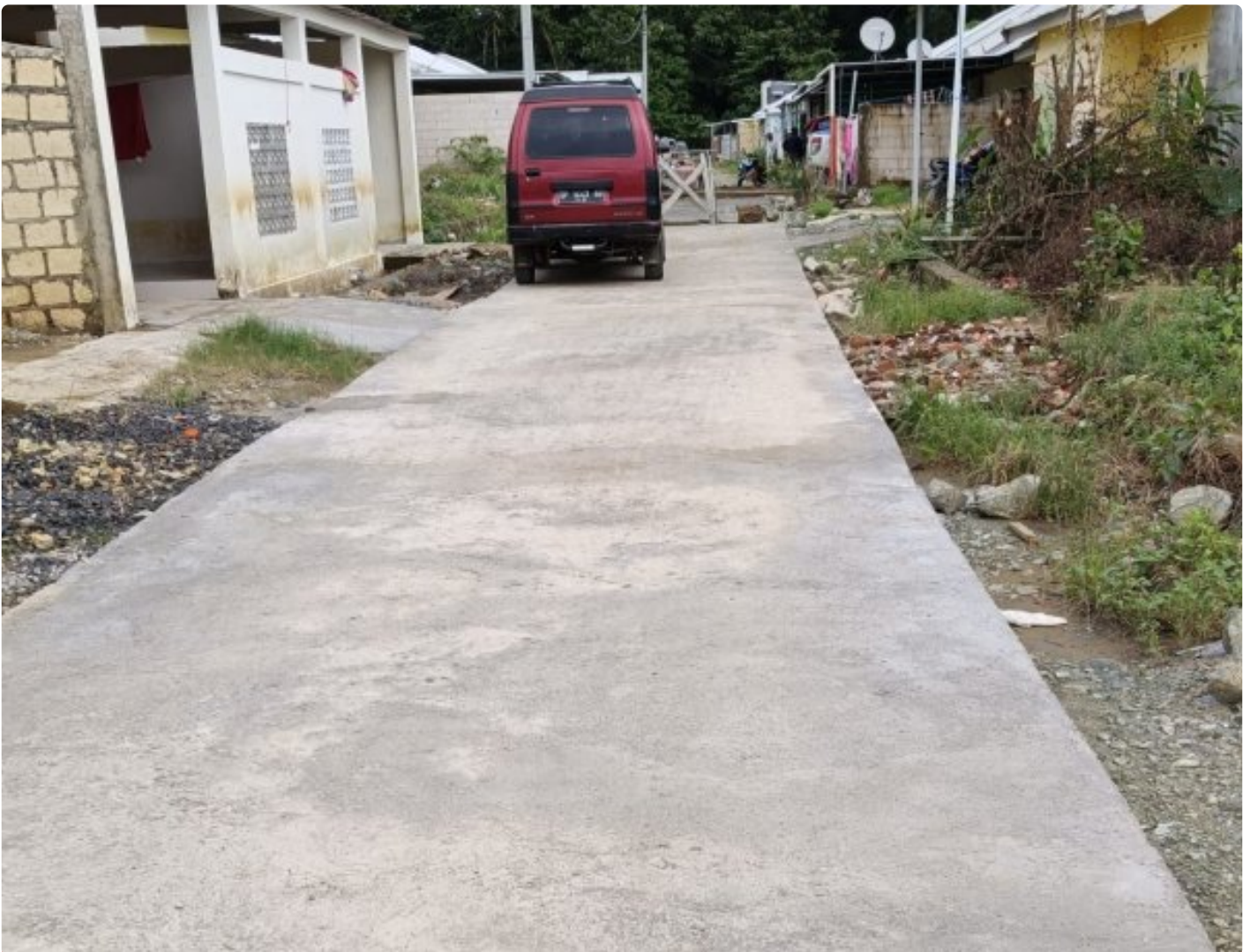
Jalan diarea perumahan BTN Ghina Sakinah usai dilakukan pengecoran
