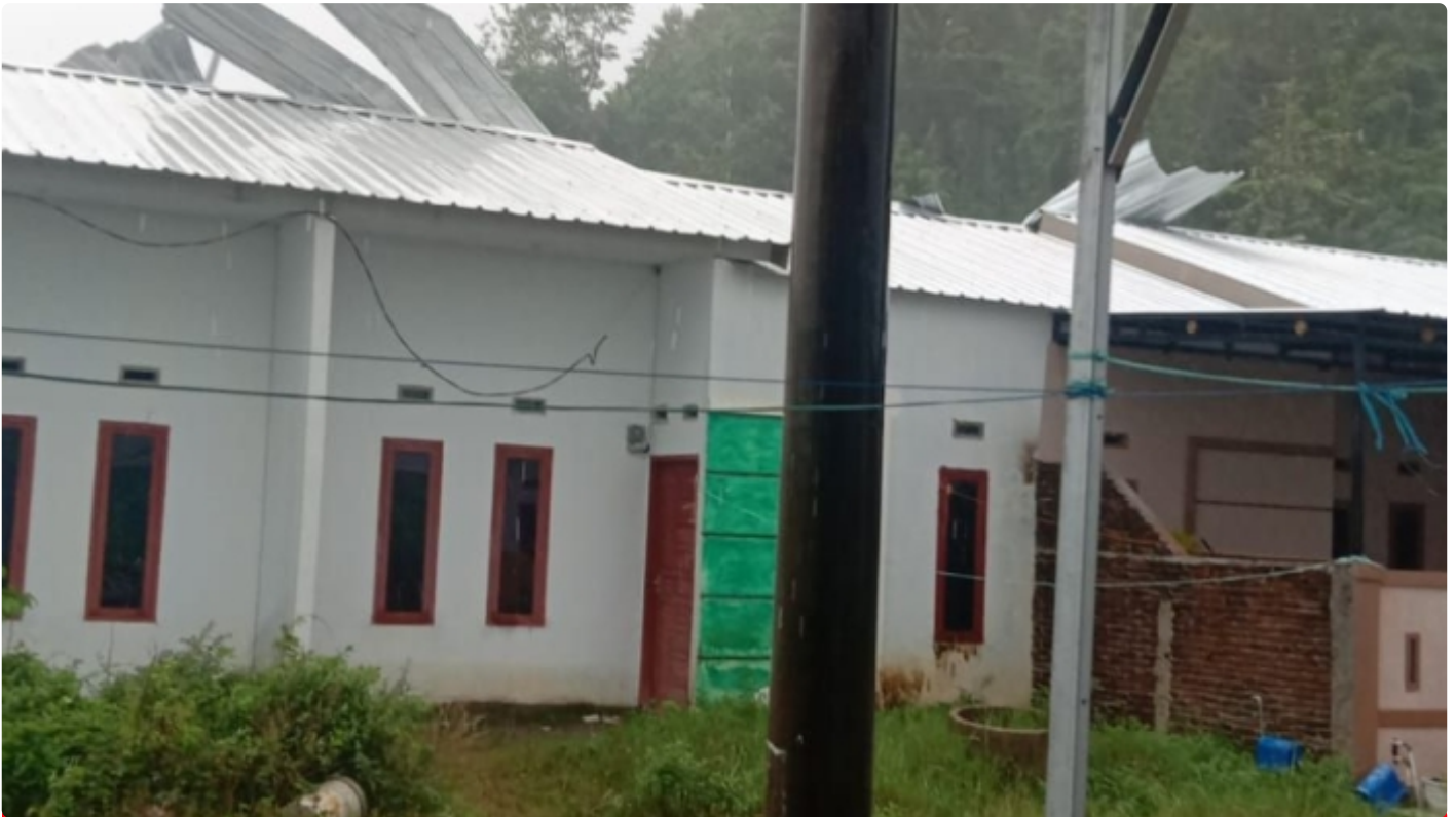
Perumahan Babana Permai Barru blok E
